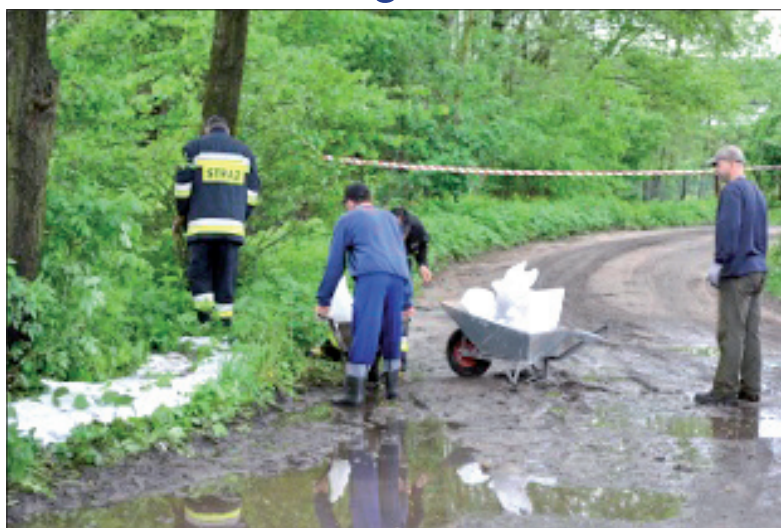
Układanie worków z piaskiem
